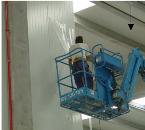
9.-PELADO DE FILM CARA INTERIOR
