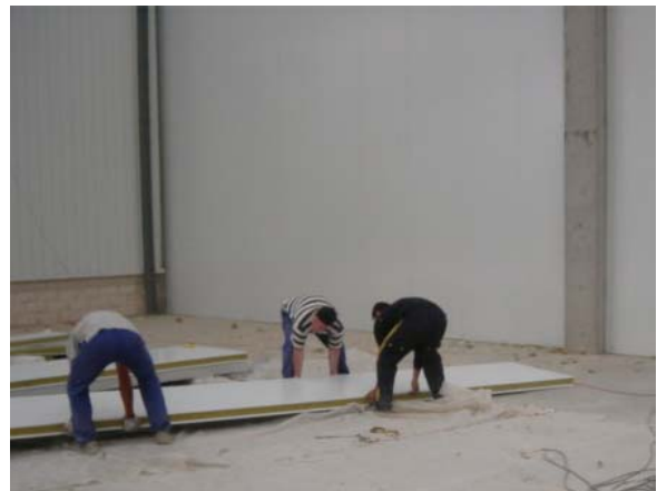
2.-POSICIONAMIENTO DEL PANEL A PIE DE PAÑO
