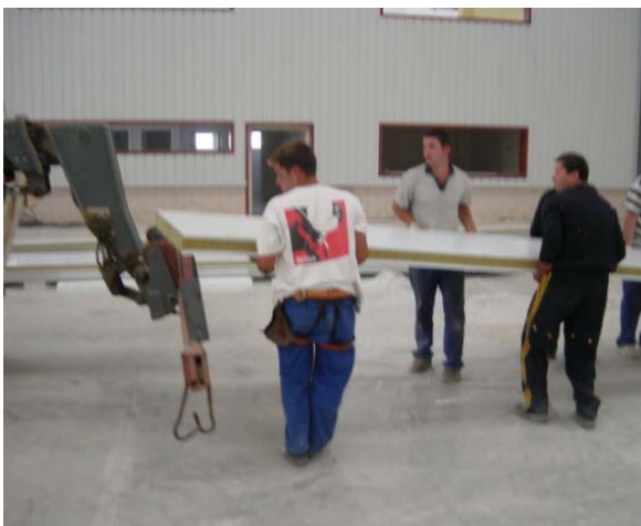
5.-POSICIONAMIENTO DE PANEL SOBRE RODILLO
