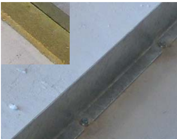
3.- COLOCACION DE ANGULAR EN SUELO Y LANA ACH-10030
