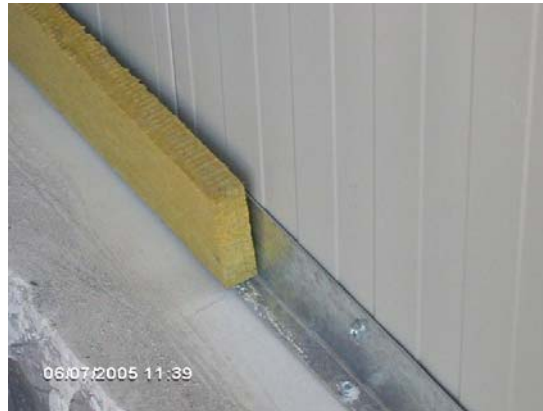
10.-PROTECCION ANGULAR ESTRUCTURAL
