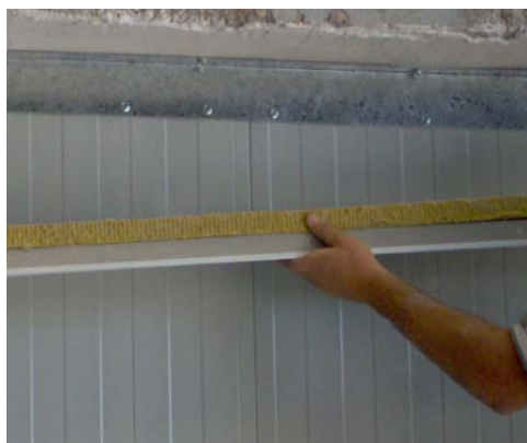
11.-COLOCACION REMATE SOBRE LANA MINERAL
