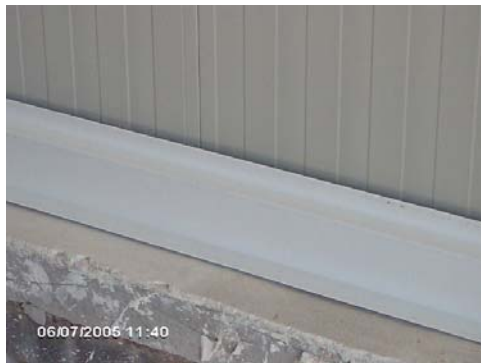
11.-COLOCACION REMATE SOBRE LANA MINERAL
